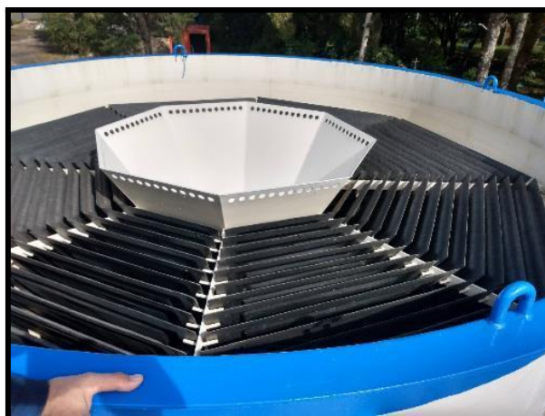
Foto 33.(b) - Decantador de alta taxa de fluxo ascendente
