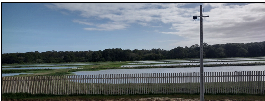
Foto 34 - Detalhes das bacias de infiltração
