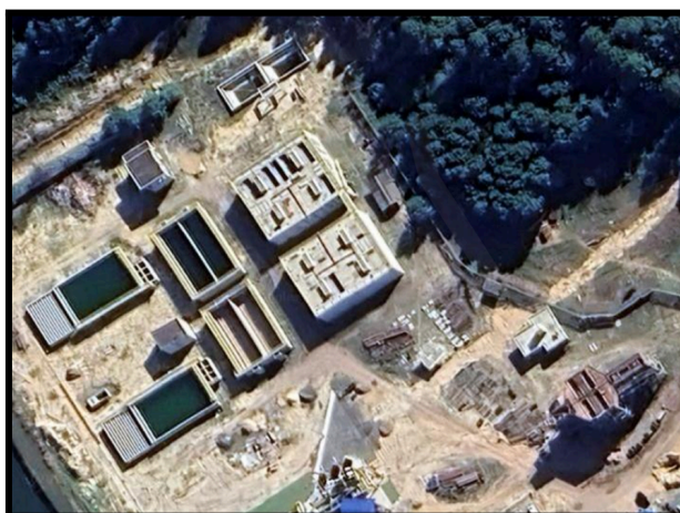
Foto 36.(a) - Visão geral da ETE convencional em construção
