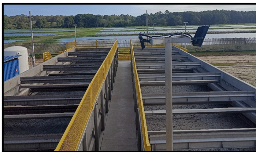
Foto 35.(b) - Flotadores com raspadores de superfície
