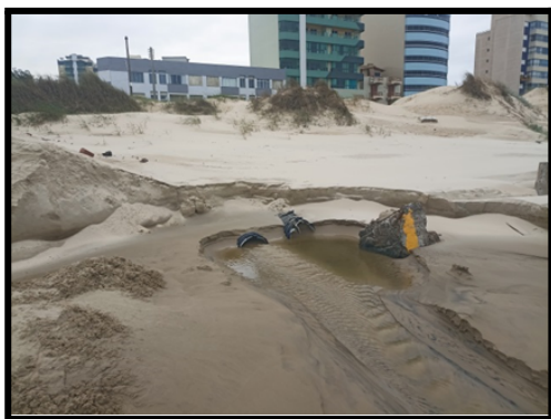
Foto 39 – Degradação da faixa de praia devido aos lançamentos de rede pluvial
