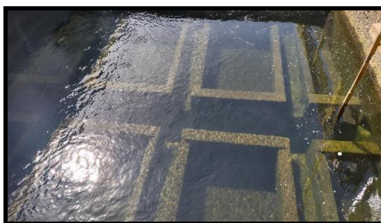
Foto 32.(f) - Filtros rápidos de fluxo descendente
