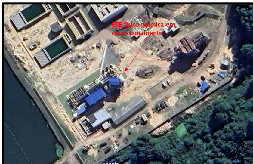
Foto 35.(a) - visão geral da ETE
